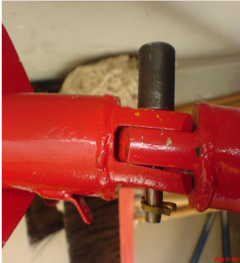
ANEXO D. (Sección del triángulo de izada unido por un pasador.)
