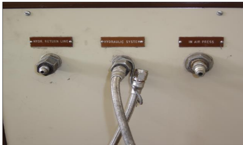
Fig. 2.11. Banco de prueba hidráulico 04-A parte trasera
