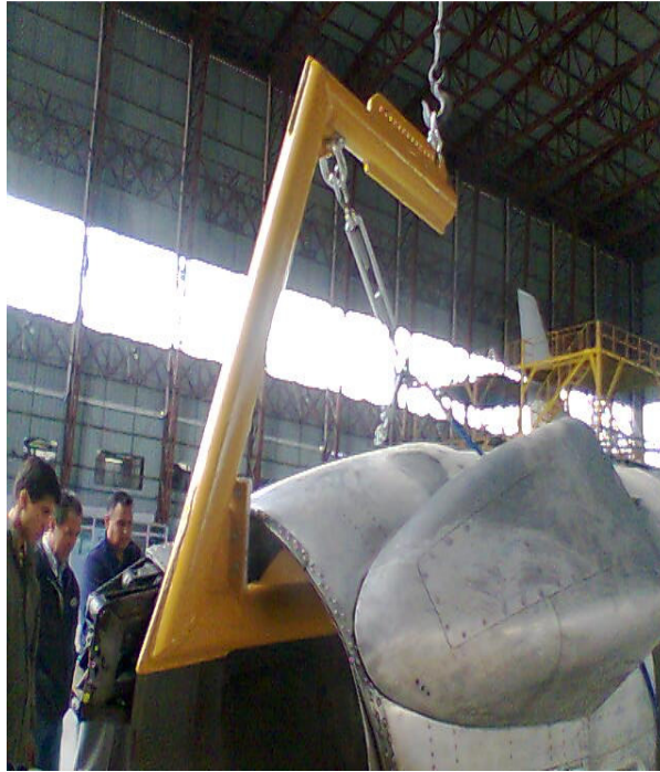
Foto Nº 5.27: Prueba de la Eslinga de Izado con carga.
