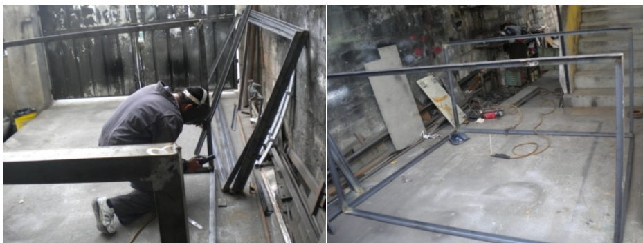
Figura 3.23 Proceso de suelda de los pisos a las columnas de las estanterías Fuente: Sr. Cuatín Ruiz Víctor Yordan
