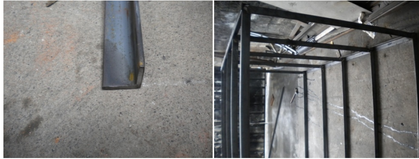
Figura 3.26 Proceso de suelda de los pisos a las columnas de las estanterías Fuente: Sr. Cuatín Ruiz Víctor Yordan
