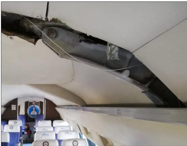
Figura 53. Desmontaje de paneles
