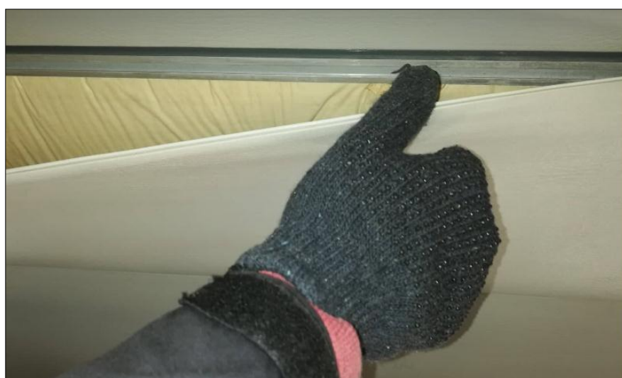
Figura 54. Desmontaje de recubrimiento
