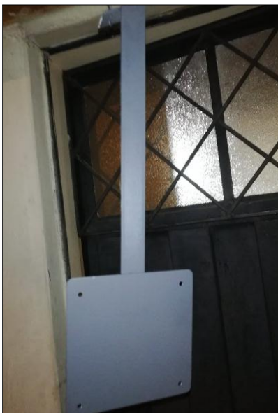
Figura 52. Capa de pintura
