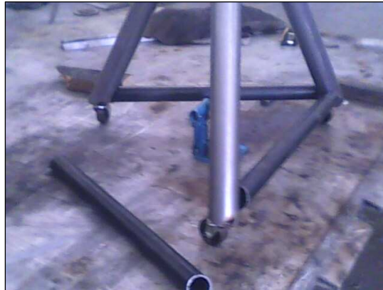
Fig. 3.16 Travesaños previo a la soldadura
