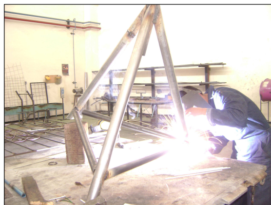
Fig. 3.12 Suelda de la estructura trípode
