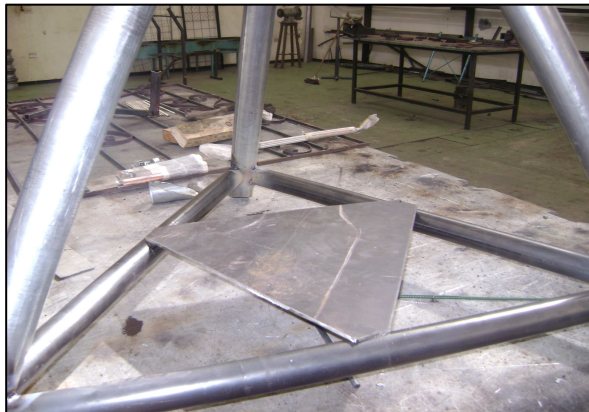
Fig. 3.20 Suelta de la base soporte a la estructura principal
