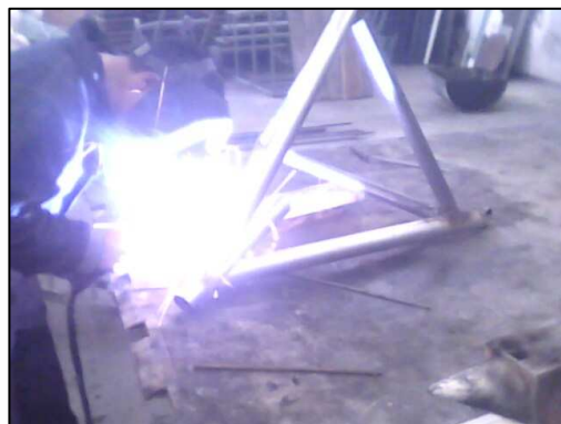
Fig. 3.18 Suelda de los pies soportantes y travesaños
