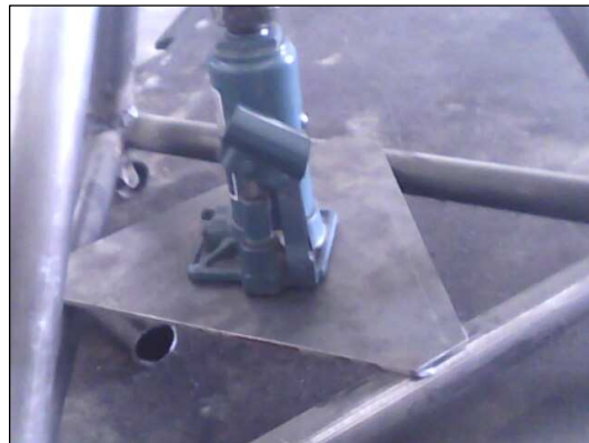
Fig. 3.22 Componentes previo a la soldadura.
