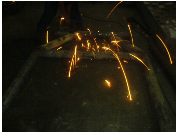
Fig. 3.10 Soldado de la estructura de la base Fuente: Taller industrial "Izurieta"
