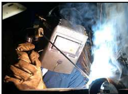
Fig. 2.3 Soldadura de arco de metal blindado
