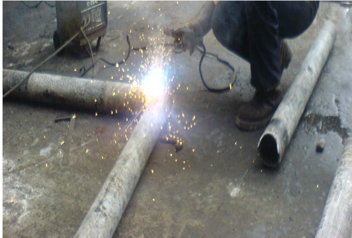
Fig. 3.9 Soldado de la estructura de la base Fuente: Taller industrial "Izurieta"
