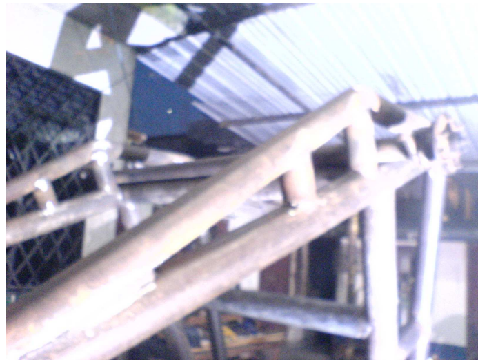
Fig. 3.12 Ensamblaje del soporte posterior a la estructura de la base Fuente: Taller industrial “Izurieta”
