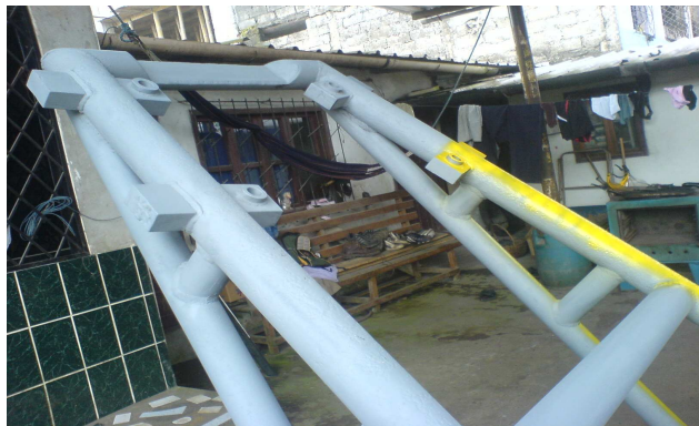
Fig. 3.15 Fondeado y pintado del soporte Fuente: Taller industrial "Izurieta"
