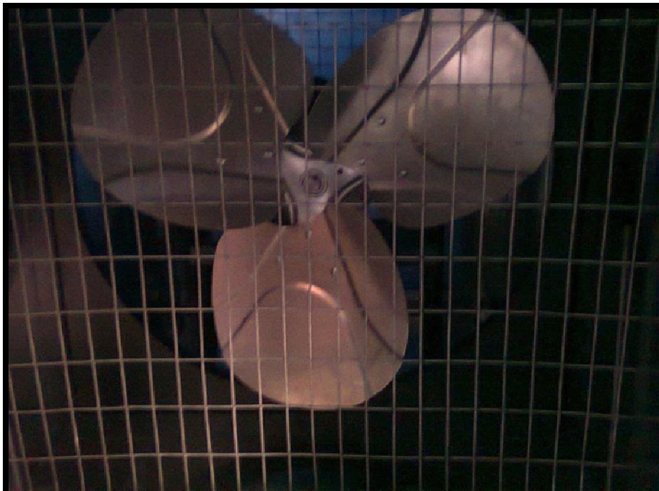
Figura E5. Chequeo de partes móviles fan blade
