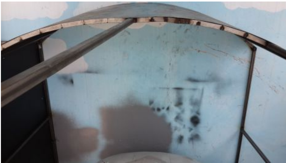
Figura 19: Vista superior de la estructura
