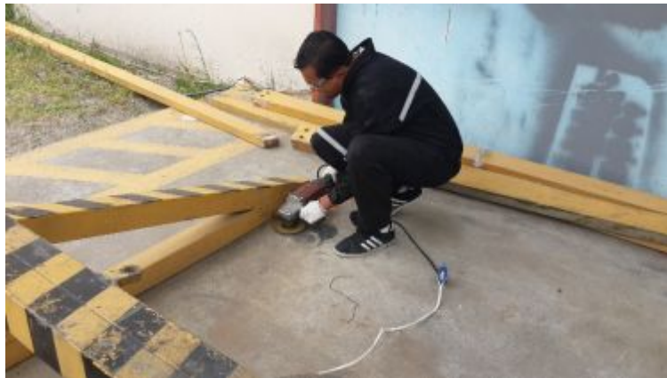
Figura 14: Proceso de cortado de la estructura anterior
