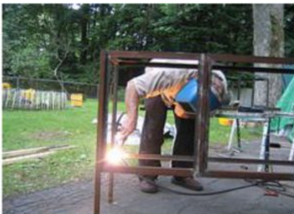
Figura 4: Suelda por arco electrico
