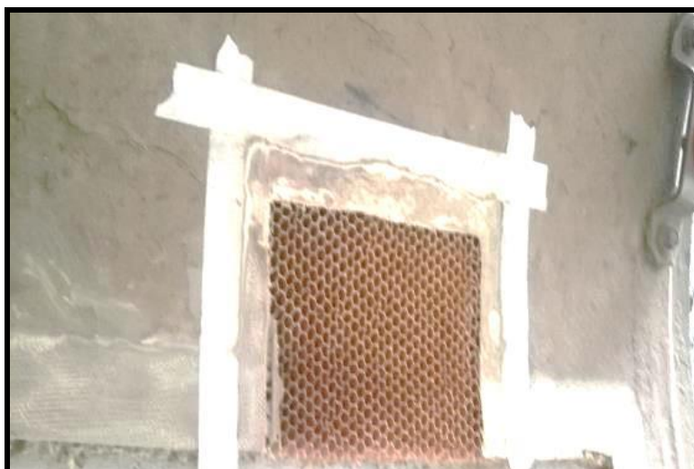
Figura 28. Lijar el Revestimiento
