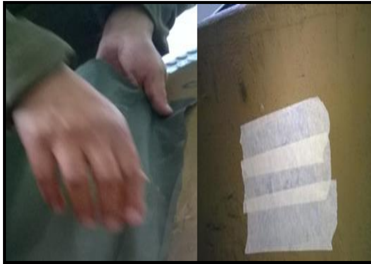
Figura 34. Colocación de la tela paraguas
