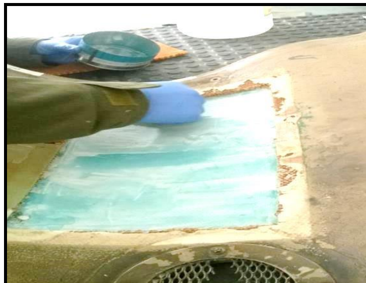
Figura 39. Aplicación de la resina sobre la Nida
