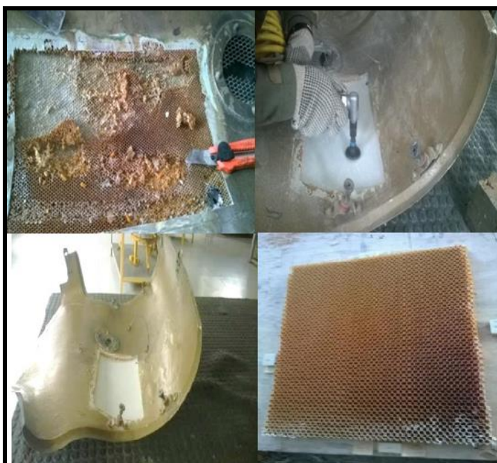
Figura 37. Cortar el trozo de Nida deteriorado y preparar el nuevo elemento de Nida.
