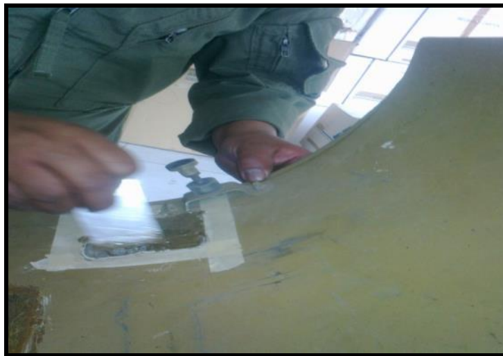
Figura 33. El pre impregnado de la tela de vidrio
