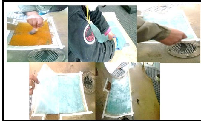
Figura 40. Colocación de la tela de vidrio en la nida.
