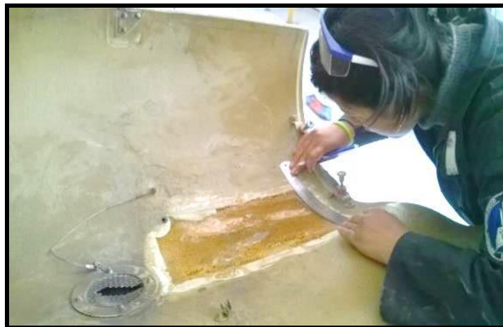
Figura 36. Lijar alrededor del revestimiento
