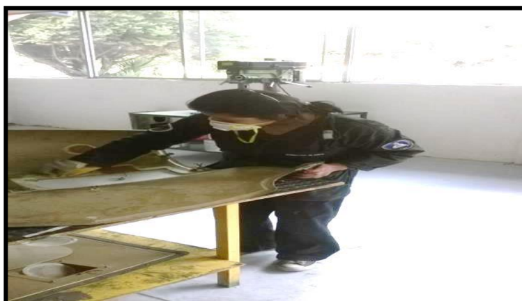
Figura 29. Limpiar el Revestimiento
