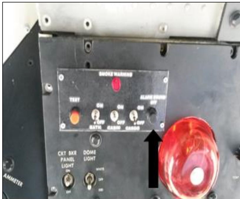
Figura 49: Panel de detección de humo
