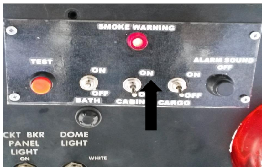
Figura 52: Panel de sistema de fuego
