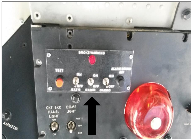
Figura 39: Panel de sistema de detección de humo.
