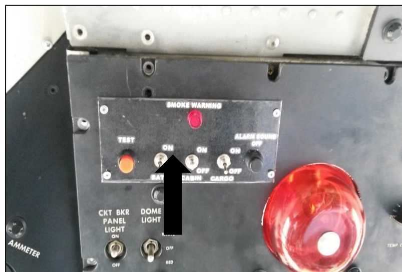
Figura 44: Panel de detección de humo
