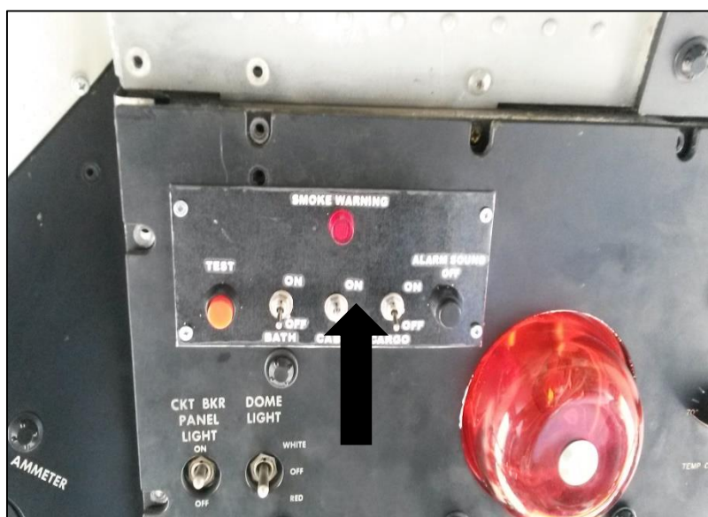
Figura 50: Panel de detección de humo
