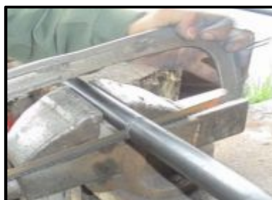
Figura 78. Proceso de corte del tubo de hierro
