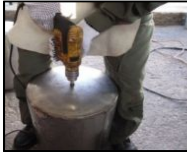
Figura 73. Proceso de perforación de los orificios en los tanques
