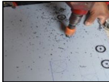
Figura 88. Proceso de corte de la placa del panel de control
