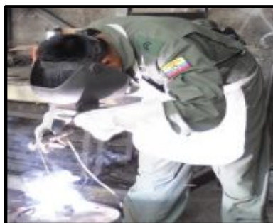
Figura 71. Proceso de suelda de las juntas de los tanques
