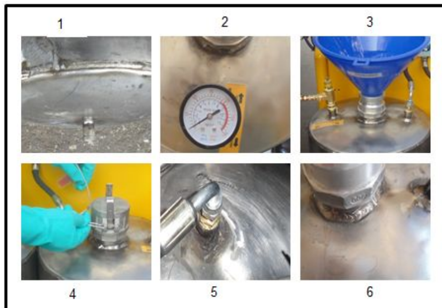
Figura 75. Proceso de comprobación de las uniones de suelda
