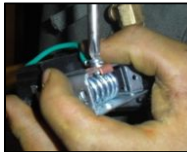
Figura 91. Conexión de los cables eléctricos
