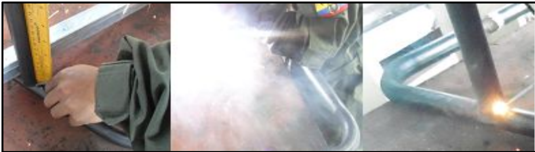
Figura 81. Proceso de suelda de las uniones del soporte
