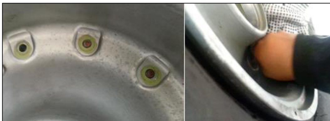
Figura 59. Intalación de los pernos de sujección
