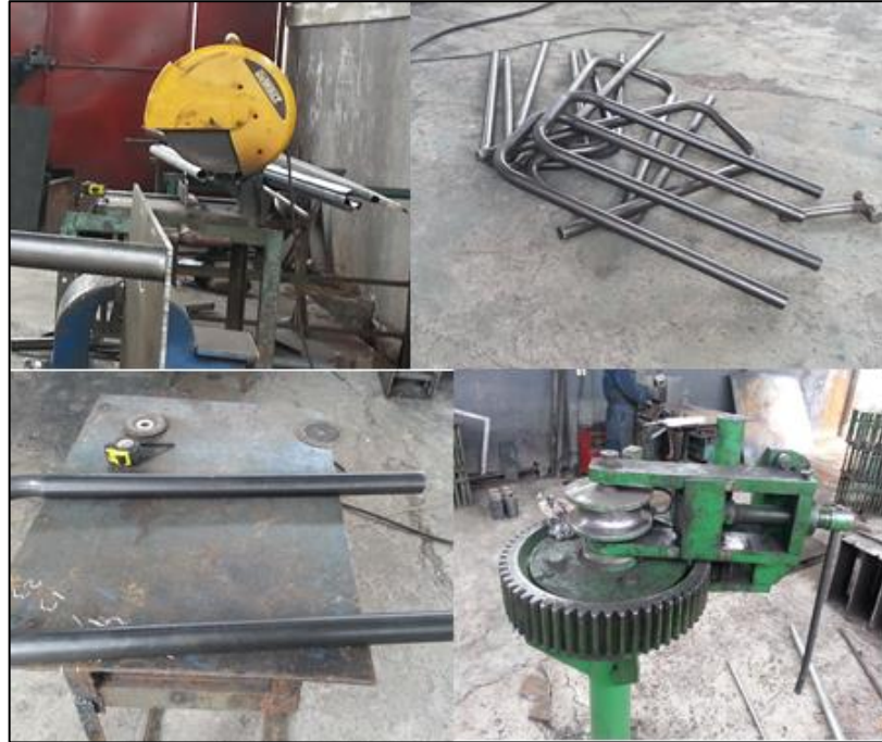
Figura 95. Tubería estructural cortada y doblada
