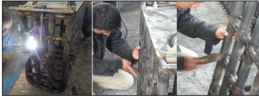
Figura 98. Limpieza de de rebabas de la jaula de seguridad
