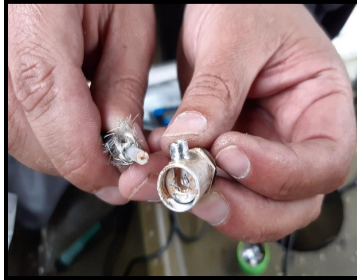
Soldadura entre el cable coaxial y el conector MB
