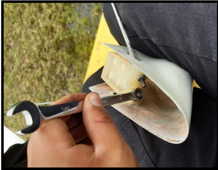
Instalación y ajuste de los dipolos de la antena VOR
