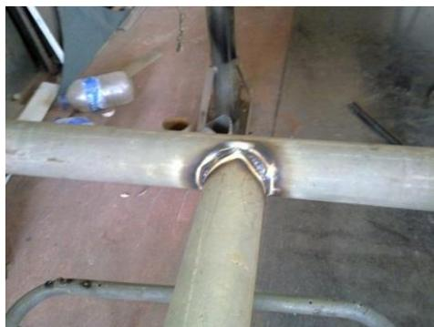
**FIGURA 3.8.2:** Soldadura del tubo base con la columna
