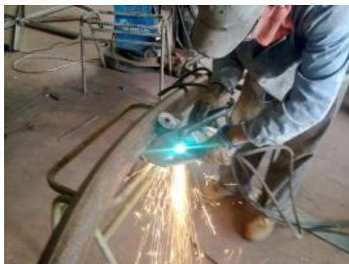
**FIGURA 3.8.17:** Platina soldada a la estructura
