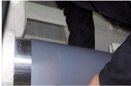
FIGURA 3.22: Doblado de las planchas de Tol
