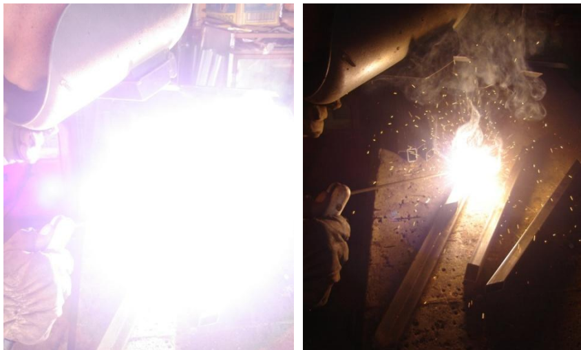
FIGURA 3.12: Soldadura de la estructura Fuente: Investigación de Campo
