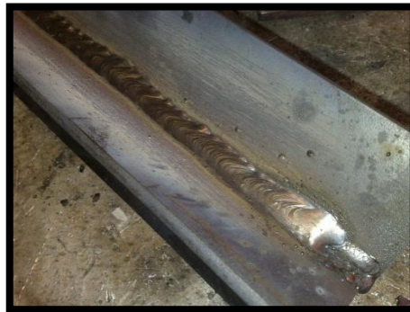
FIGURA 2.31 Cordón de Soldadura
