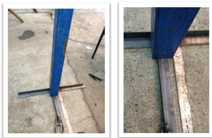
**Figuras 13:** Nivelación del tubo con los ángulos
