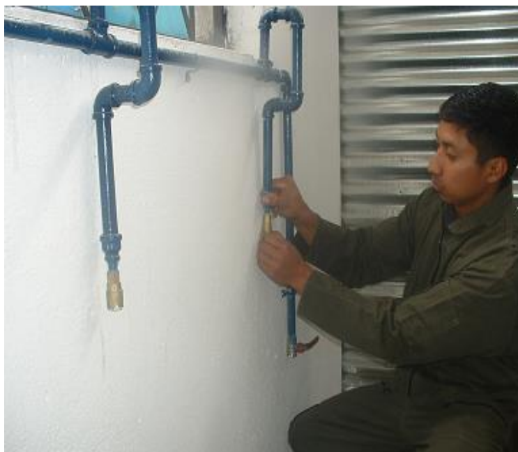
Fig. 3.8 Colocación de toma de aire.
