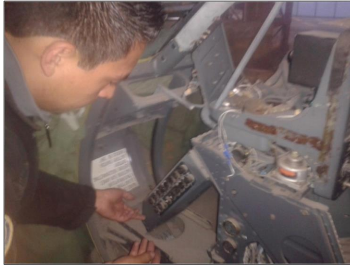
Figura 3. 20 Colocación de los tornillos faltantes en los paneles de fusibles
