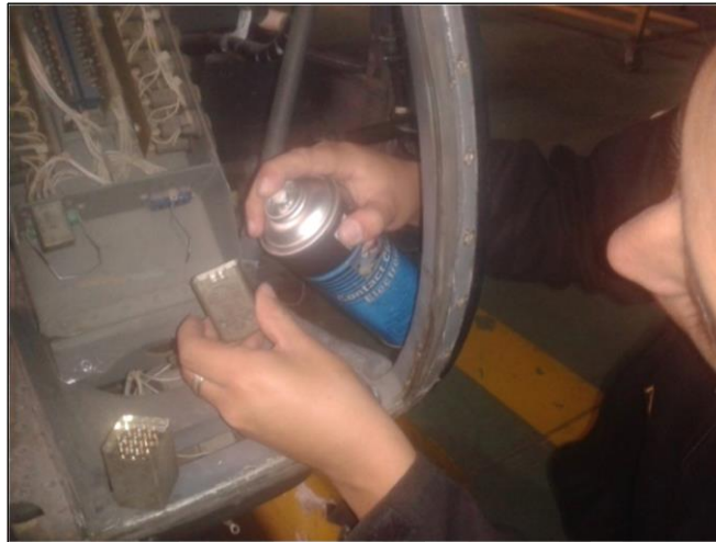
Figura 3. 25 Limpieza de relés y contactos de los paneles
