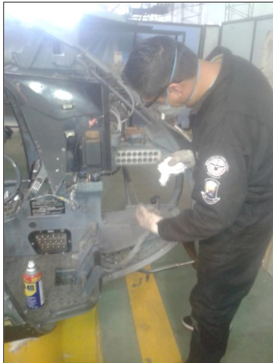
Figura 3. 19 Limpieza del panel de fusibles
