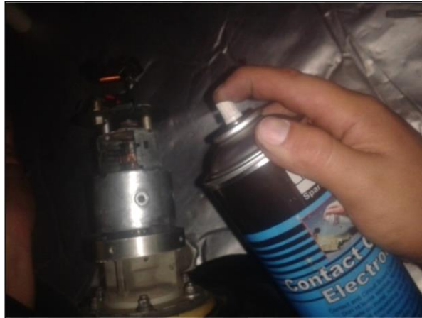
Figura 3. 10 Reemplazo de los contactos y limpieza de la bomba de cebado
