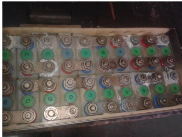
Figura 3. 22 Rehabilitación de la batería de 28V
