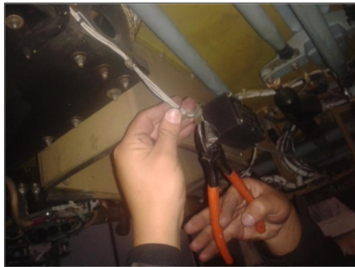
Figura 3. 15 Sujeción del cableado eléctrico con las amarras
