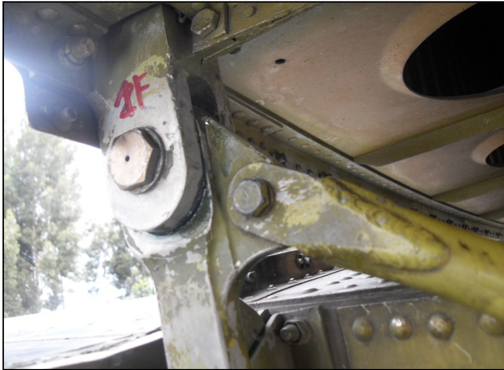
Figura 3.16: Perno colocado en el fitting
