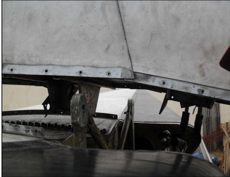
Figura 3.10: Alineación parcial de los fittings
