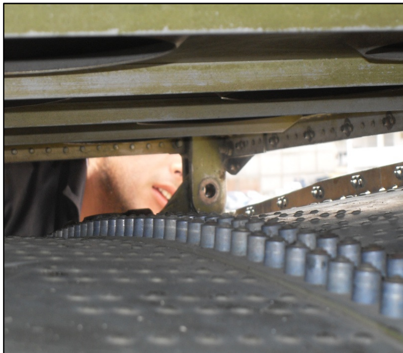
Figura 3.11: Alineación completa de los fittings
