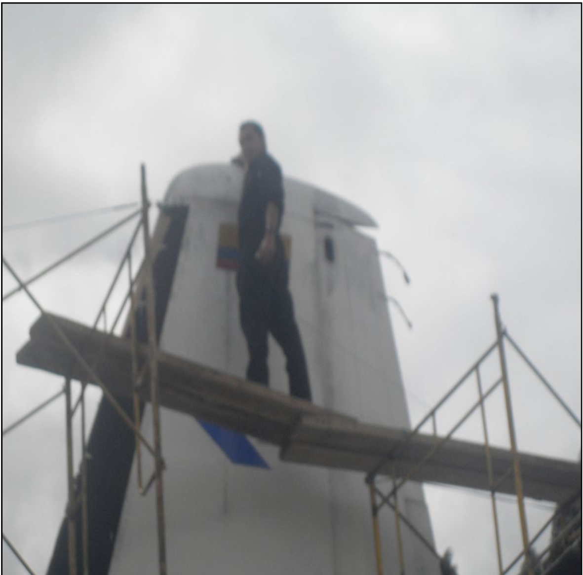
Figura 3.31: Instalación de la Punta del estabilizador
