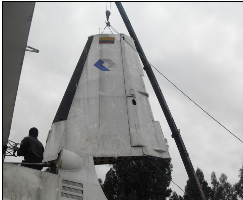
Figura 3.8: Alineación parcial del estabilizador vertical
