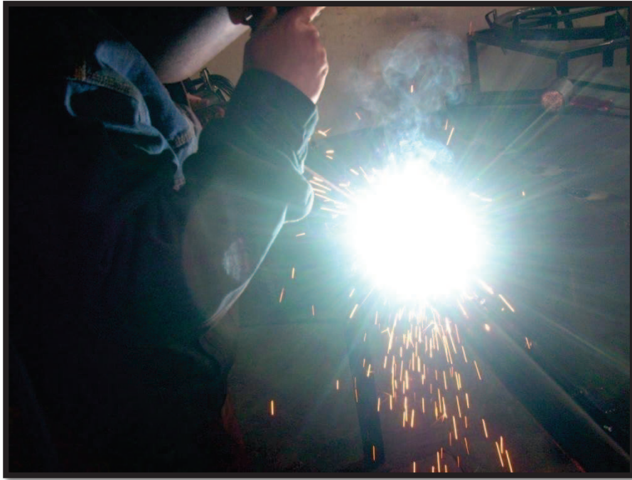
Figura 3.12 Soldadura de la estructura
