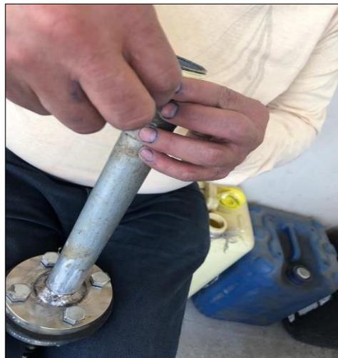
**Figura 30** Colocación del teflón en la rosca
