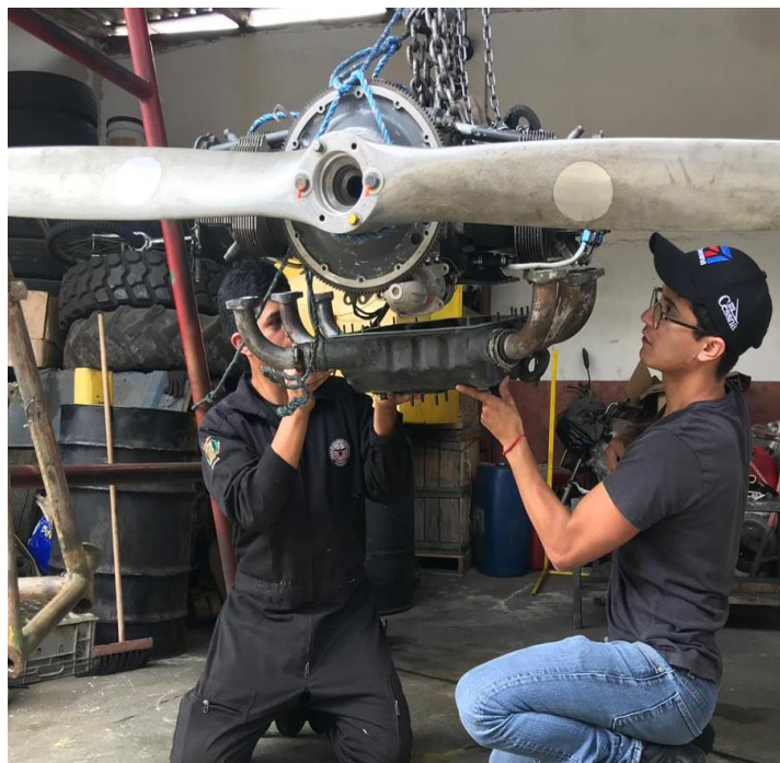
Figura 37 Instalación tanque de aceite
