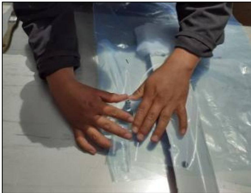
Figura 49 Preparado zona de curado
