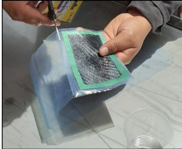
Figura. 45 Marcar área de reparación
