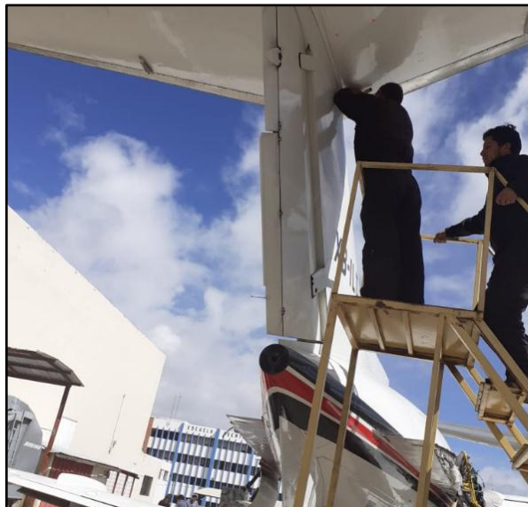
Figura 34 Desmontaje de parte
