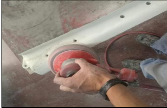
Figura. 54 Lijado de la parte sobrante de curado en el carenado
