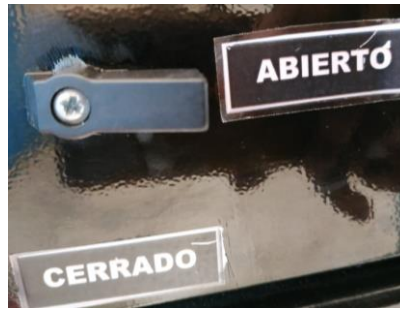
Figura 16 Válvula de Bola Manual Abierta
