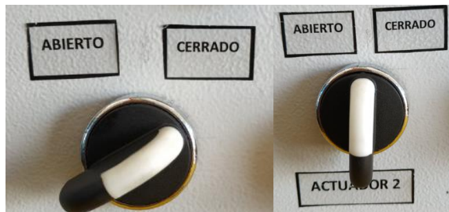
Figura 17 Accionamiento en posición CERRADO y NEUTRO
