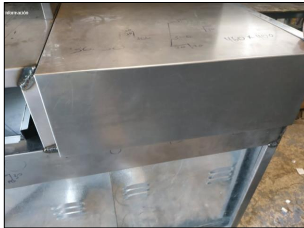
Figura 29 Unión de secciones mediante soldadura.
