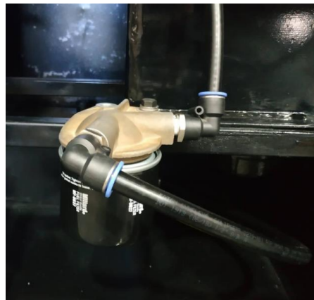
Figura 45 Conexiones de las cañerías.
