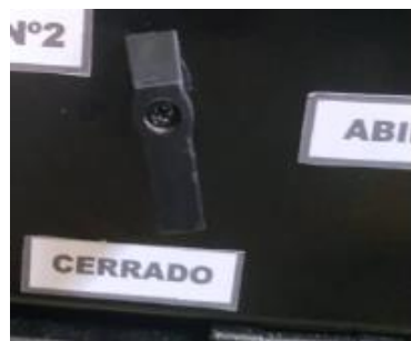
Figura 18 Válvula de Bola Manual Cerrada
