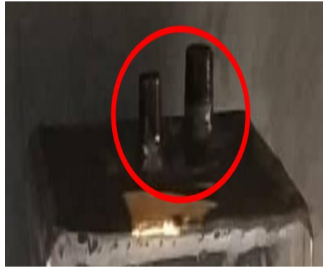
Figura 39 Niplos soldados en el reservorio.
