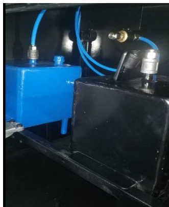
Figura 40 Reservorios de Combustible.
