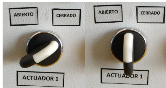
Figura 8 Accionamiento en posición CERRADO y NEUTRO
