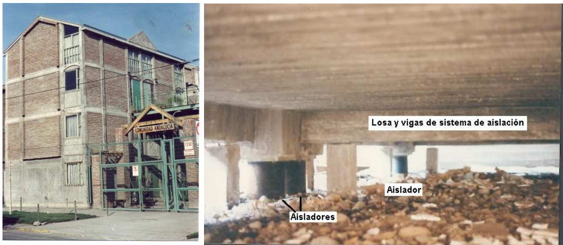
Figura 1 Edificio Andalucía con aisladores de base elastoméricos. Moroni et al. (2010).
