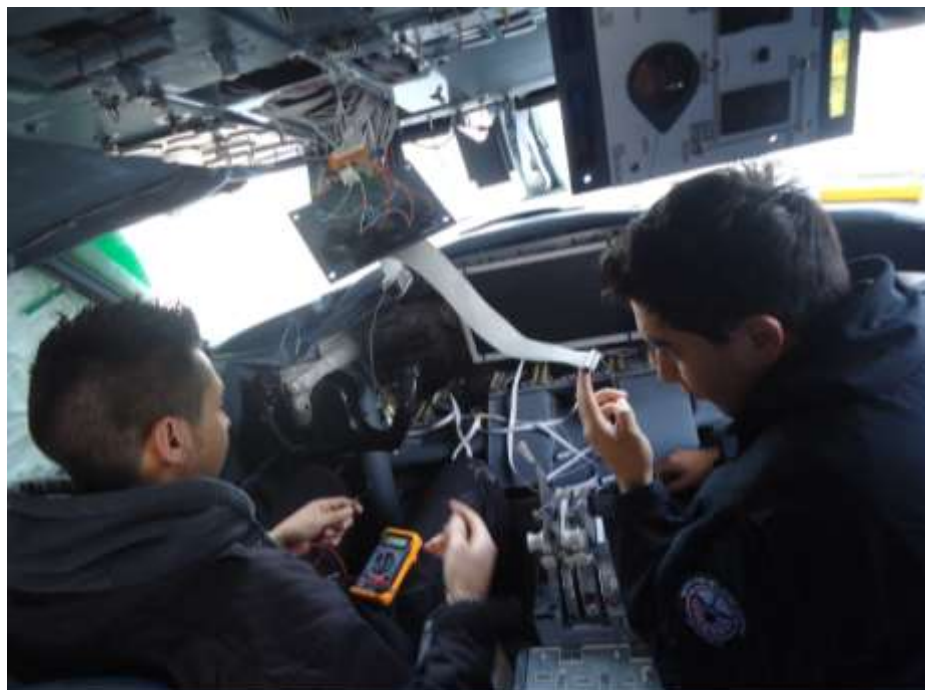
Figura 3.7 Desmontaje de los paneles para conexión de la expansión.
