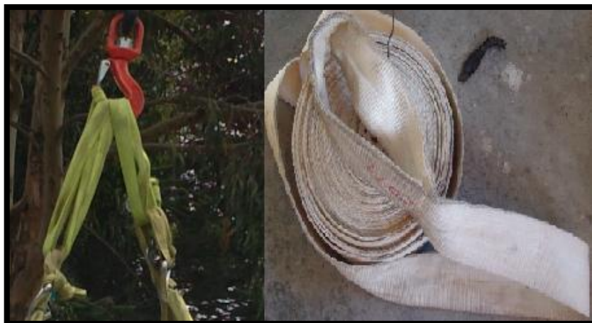
Figura 3.24: Colocación de las fajas y gancho de la grúa Elaborado por: Jonathan Zurita
