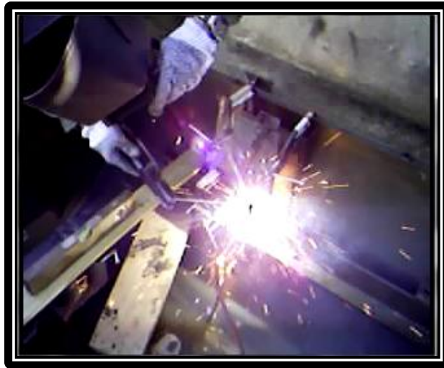
Figura 3.7 Soldadura de la Estructura
