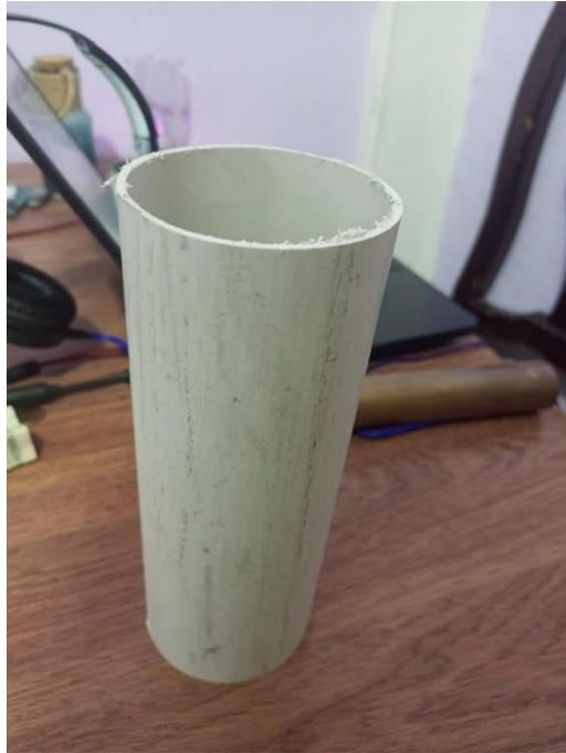
2) Se perfora a los costados del tubo de PVC un agujero de diámetro 20mm en la parte superior izquierda y parte inferior derecha, lo cuales serán para el flujo de entrada y salida del intercambiador, los cuales deben estar a una distancia de 30mm desde la tapa.
