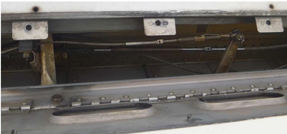
Figura 2.29: Turnbuckles de los Trim cables
