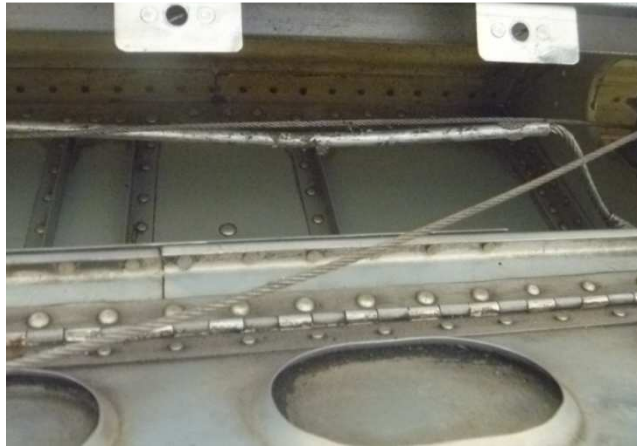
Figura 3.14: Paneles de acceso abierto en el ala derecha
