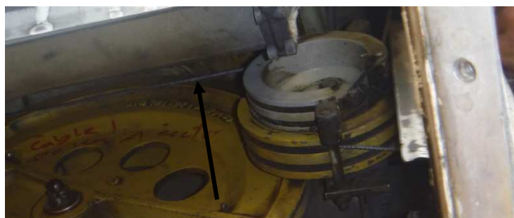
Figura 3.13: Cables que salen del Sector intermedio
