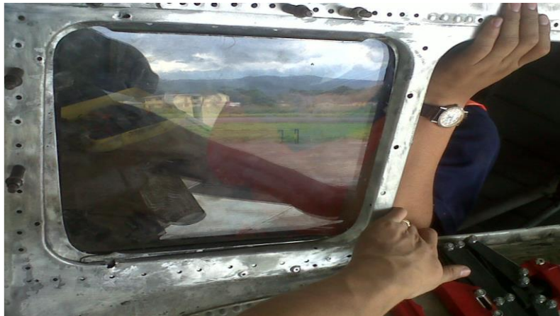
Figura 3.13. Instalación de ventanas y marcos
