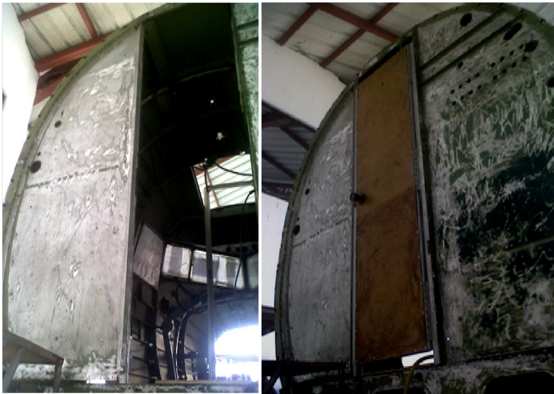
Figura 3.10. Montaje de conjunto de puerta de acceso a la cabina
