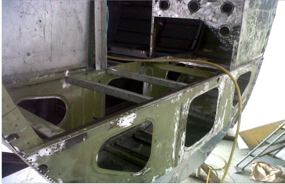
Figura 3.7. Incorporación parte estructural posterior
