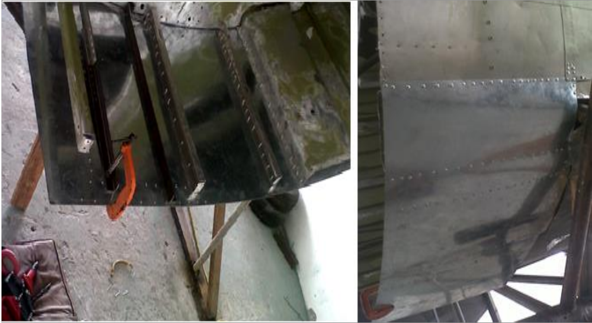
Figura 3.6. Lamina instalada Fuente: Investigación de campo
