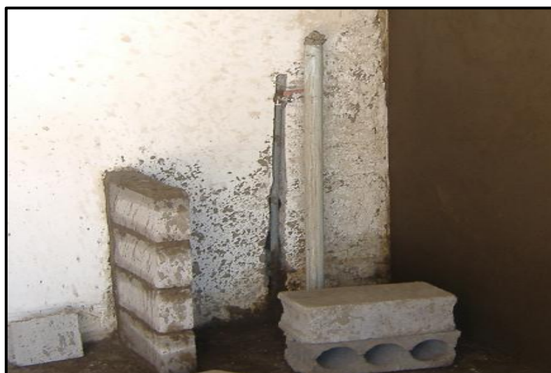
Figura 3.27 Construcción del Lavabo
