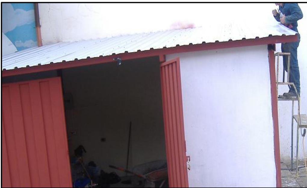
Figura 3.22 Instalación de Duratecho
