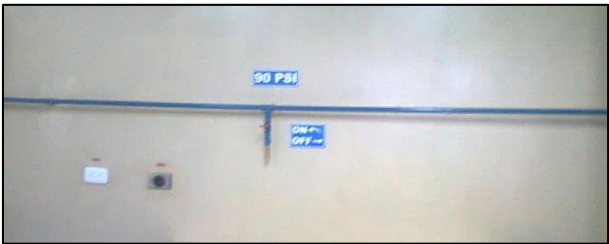
Figura 3.47 Toma neumática central
