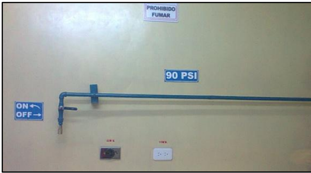
Figura 3.46 Toma neumática lateral
