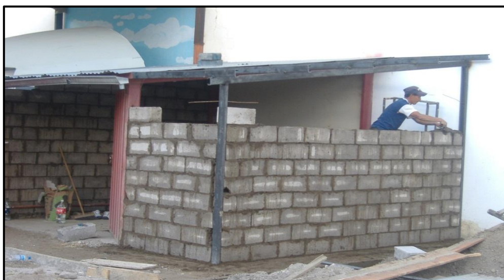
Figura 3.18 Proceso de construcción
