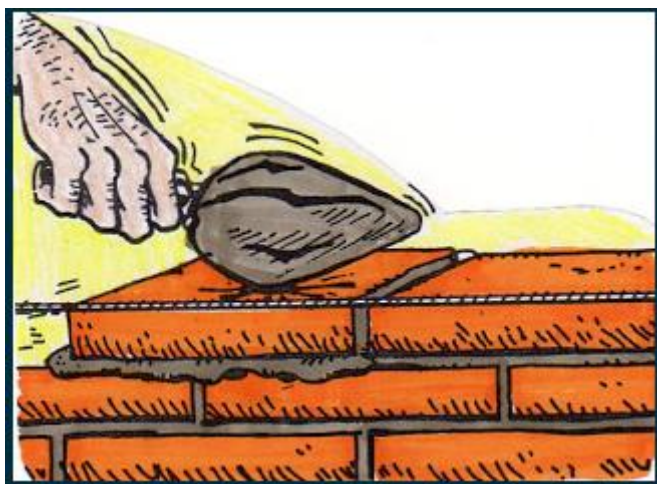
Figura 3.17 Levantamiento de la pared frontal
