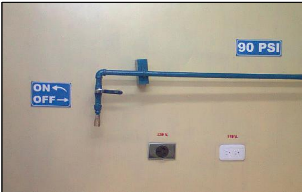
Figura 3.31 Instalación de acoples rápidos
