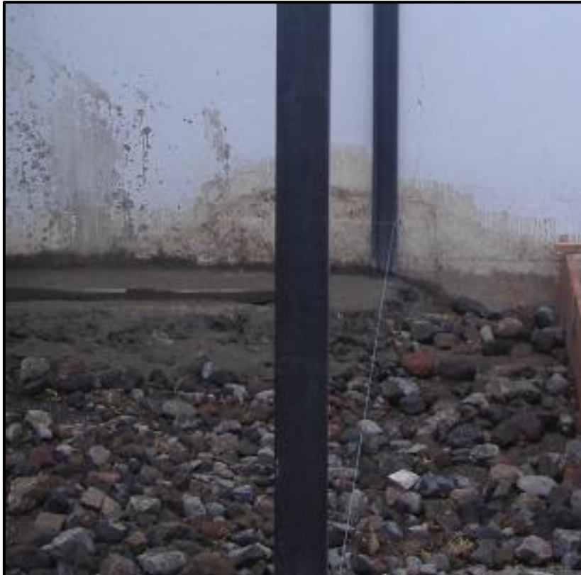
Figura 3.7 Empedrada del piso
