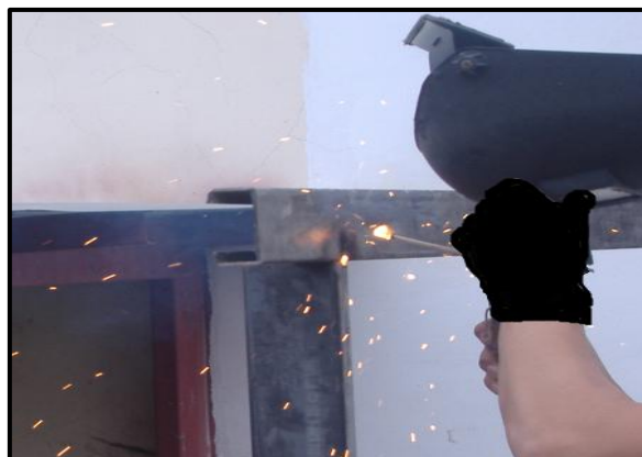
Figura 3.5 Soldadura de las Correas
