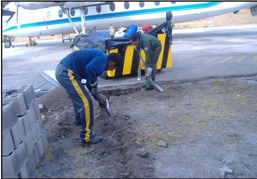
Figura 3.24 Línea de abastecimiento hacia el Taller
