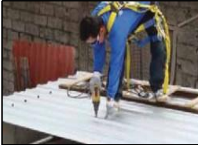
Figura 3.21 Fijación de los tornillos
