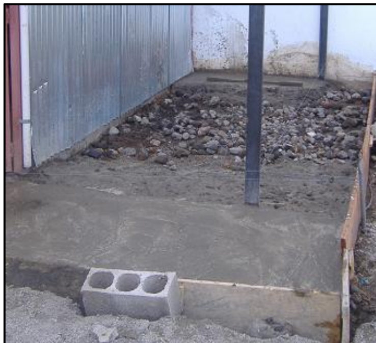
Figura 3.8 Piso Fundido
