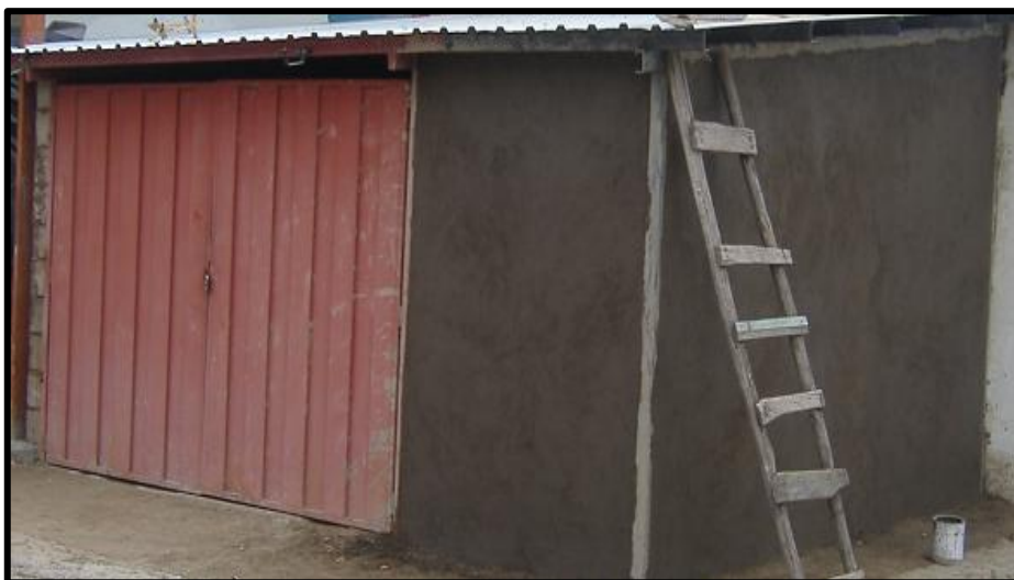
Figura 3.19 Enlucido de las paredes
