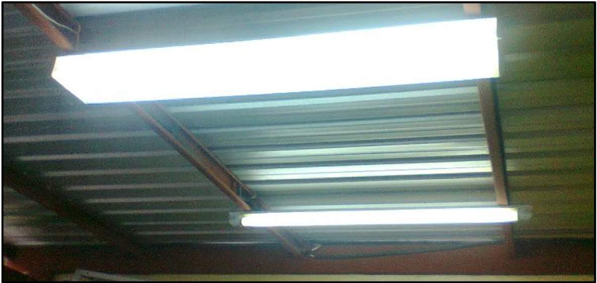
Figura 3.37 Instalación de iluminación
