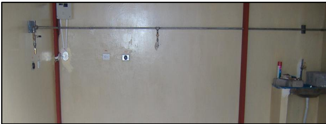
Figura 3.29 Instalación del tubo galvanizado
