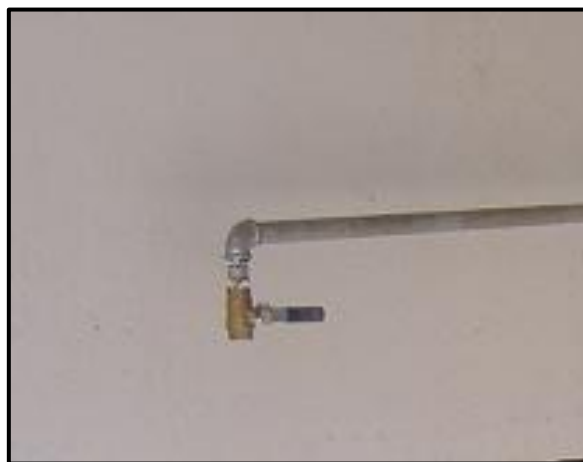
Figura 3.30 Instalación de la llaves de paso
