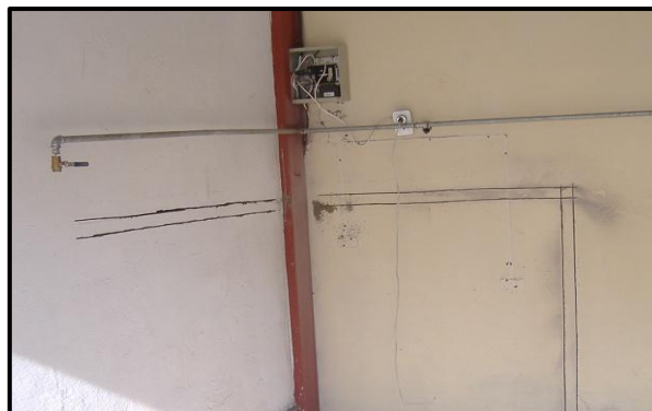
Figura 3.33 Trazo posición de tomas
