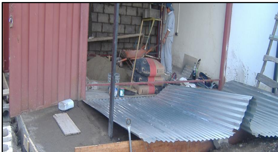
Figura 3.4 Remoción de la pared lateral derecha
