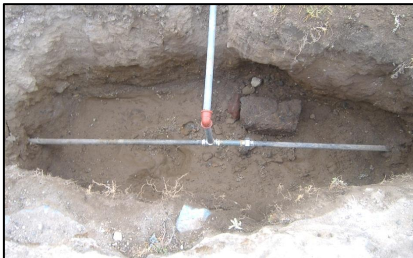
Figura 3.25 Instalación a la línea principal
