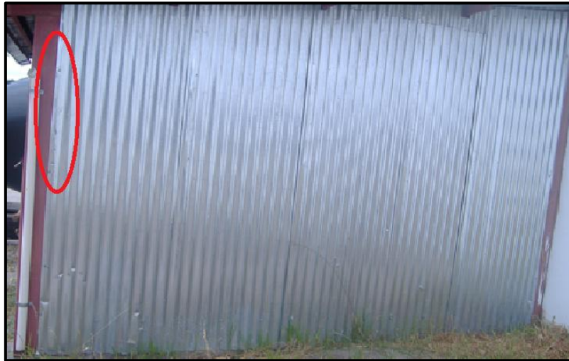
Figura 3.3 Remoción de la pared lateral izquierda
