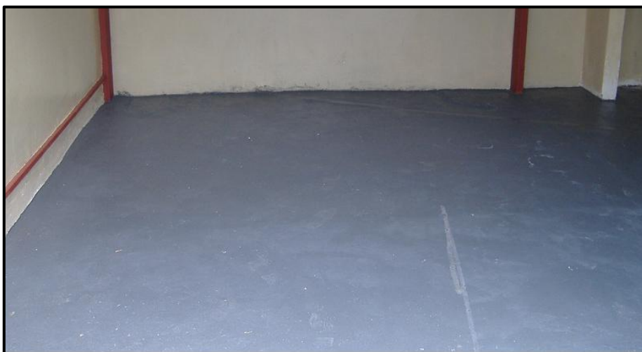
Figura 3.41 Pintura del Piso
