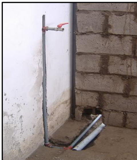
Figura 3.26 Proceso de instalación a la línea principal
