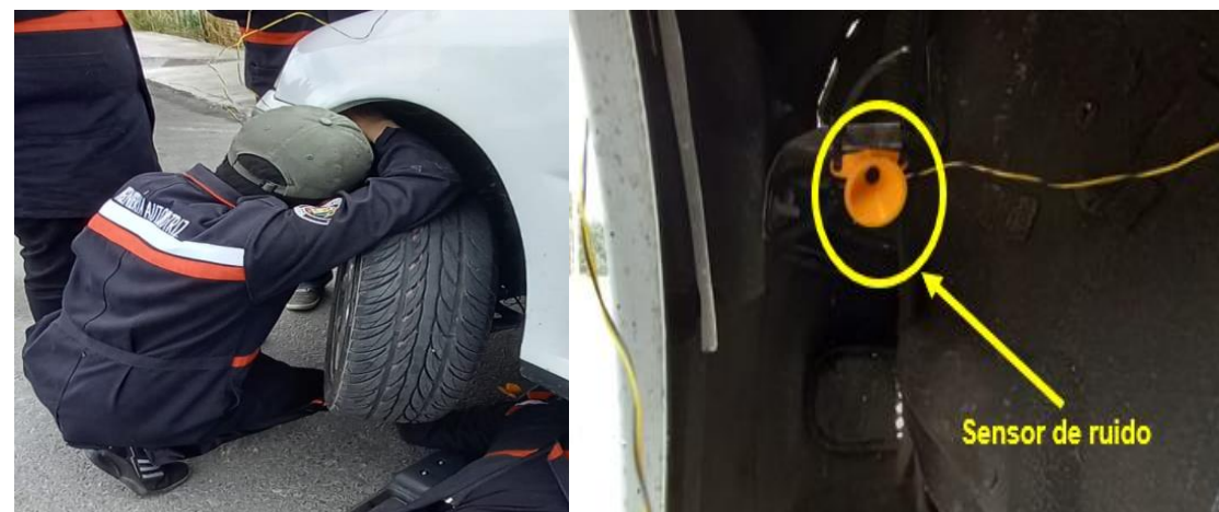
Instalación del sensor de ruido
