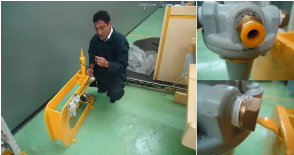
Figura 3. 13. Conexión cañerías
