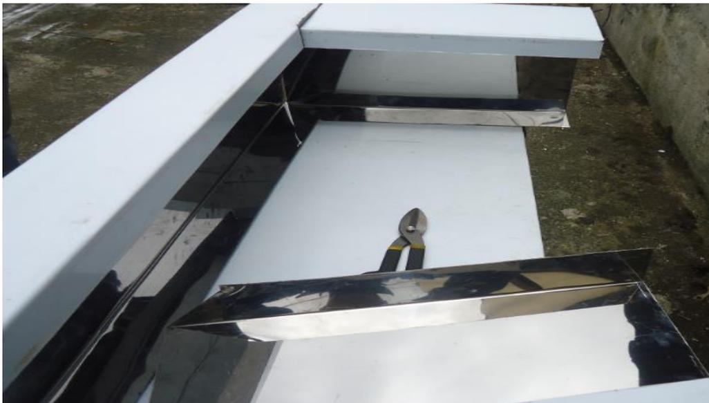
**Figura 3.4** Corte y doblado de la parte frontal y diagonal
