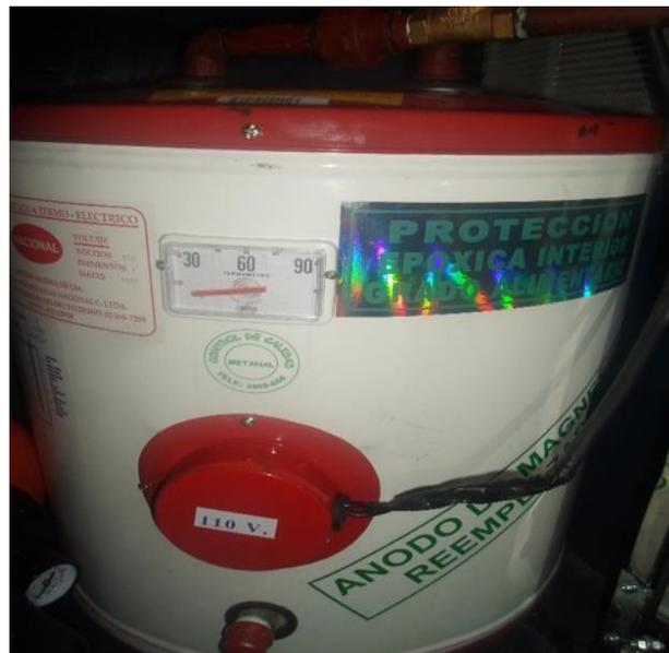
**Figura 2.14** Calentador de acumulación de 50 litros
