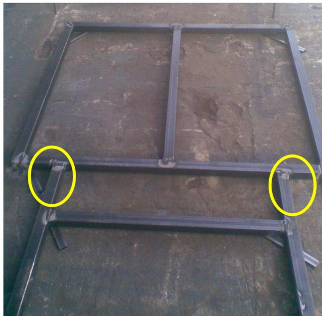
*Figura 3.37 Tubos estructurales de 40x40mm soldados al centro de la base*
