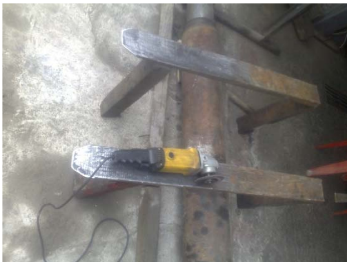
Figura 4.5 Eliminación de escorias
