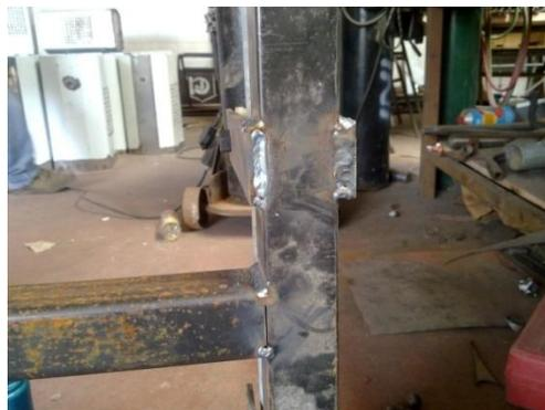
**Figura 3.17:** Montaje de la parte fija y móvil de la estructura
