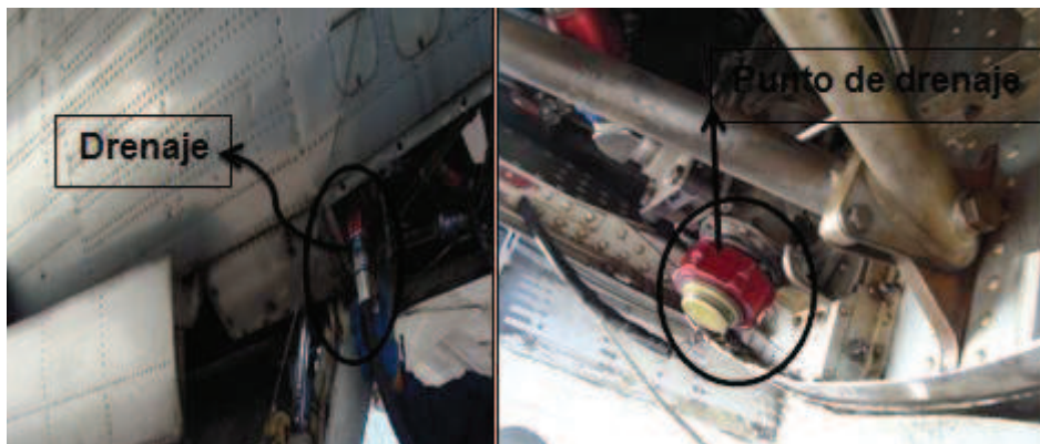
Figura 3.7: Punto de drenaje, y drenaje del motor. Elaborado por: Alfonso Carrión
