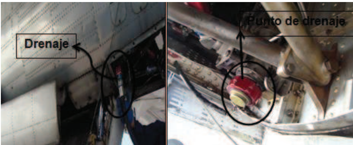
Imagen E2: Punto de drenaje
