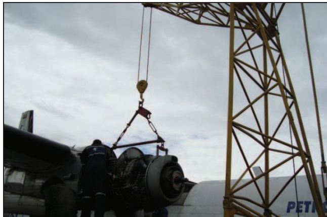
Figura 3.17: Motor izado.
