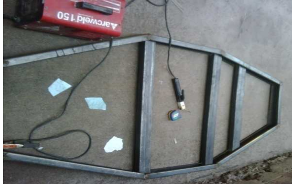
Figura 3.16: Segmentos soldados a la estructura
