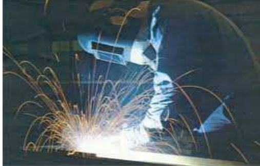
Figura 2.27: Soldadura de arco
