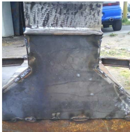
Figura 3.22: Soldadura y esmerilado de plancha para las columnas de sujeción
