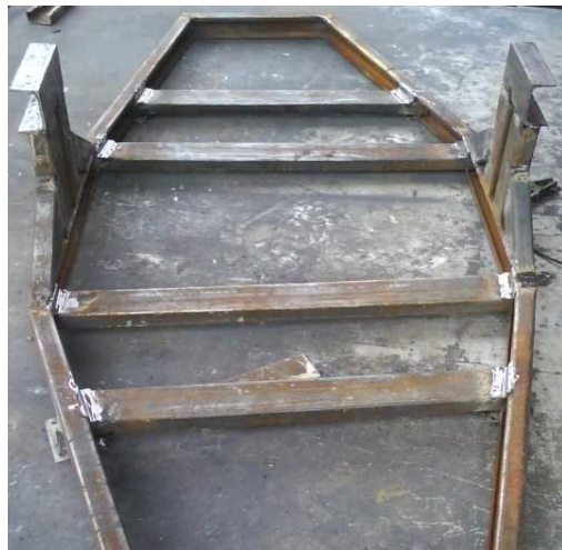
Figura 3.20: Estructura y columnas de sujeción
