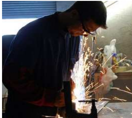
Figura 3.12: Corte del material
