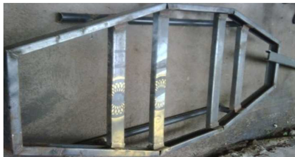
Figura 3.17: Soldadura completa de la estructura
