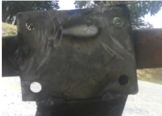
Figura 3.27: Placas soldadas a la estructura
