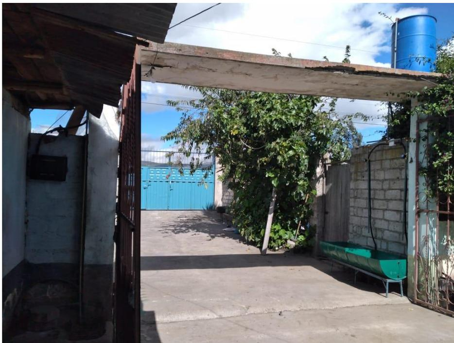
*Nota:* En la siguiente figura se visualiza el sistema de suministro de agua, desde la toma de agua ubicada en la columna izquierda hacia el tanque de almacenamiento en la parte superior de la entrada al establo y bajando hacia los bebederos.
