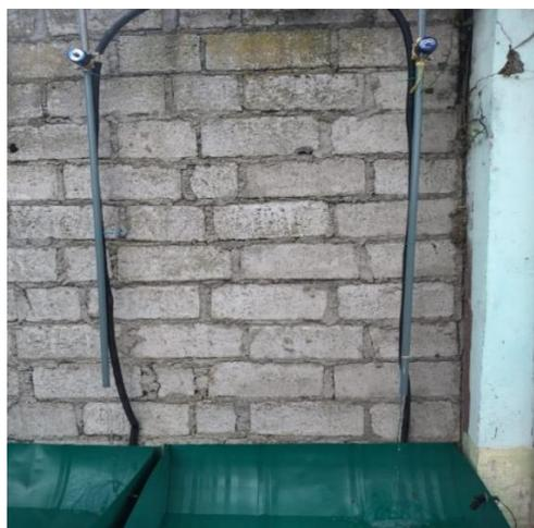
*Nota:* La siguiente figura representa las válvulas solenoides con la compuerta abierta, permitiendo el suministro de agua a los bebederos.
