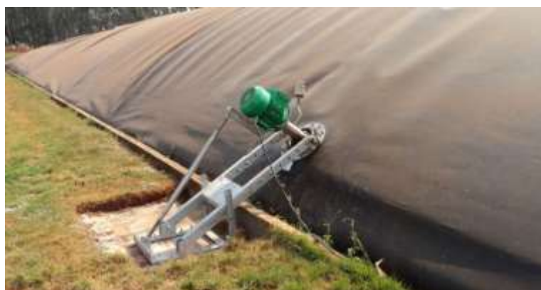
Agitador para Biodigestor Tubular
