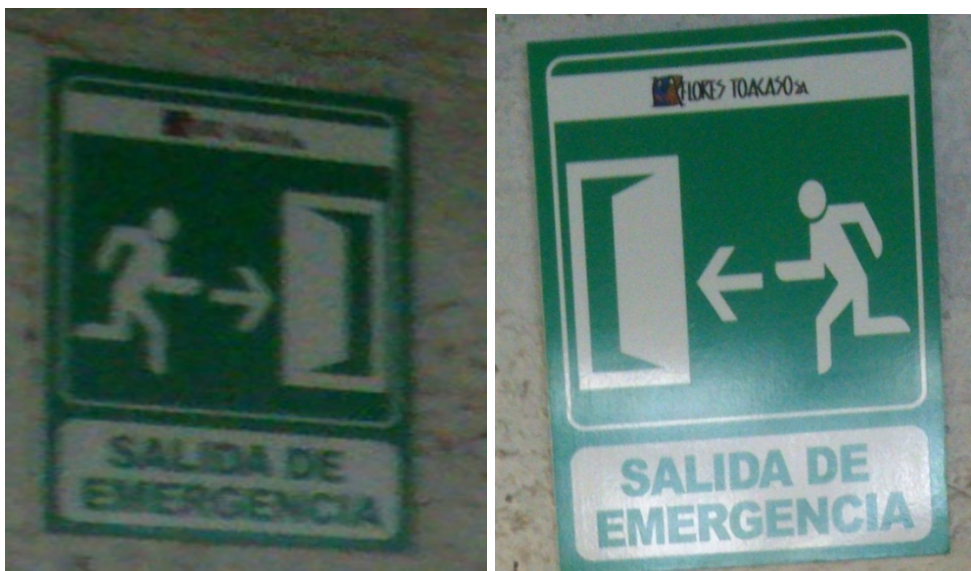
Figura N° 3.41. Salidas de emergencia
