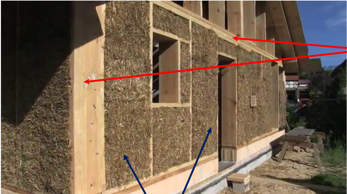
Sistema resistente: Mochetas y vigas
