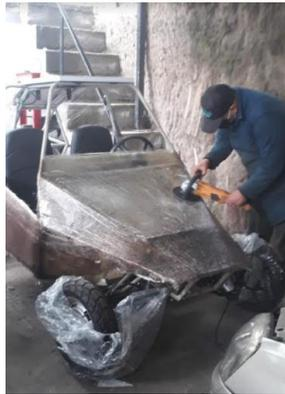
*Nota.* En la siguiente figura se puede observar el proceso de lijado de la superficie. Obtenido de (Pardo, 2022)
