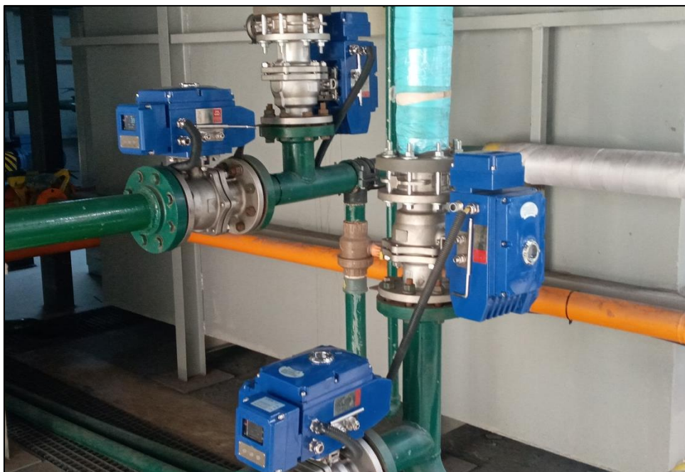
Instalación de las Servo válvulas
