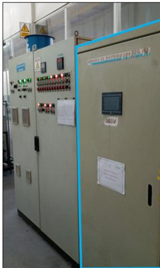
Instalación del tablero principal
