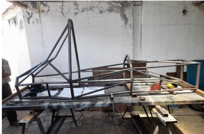
*Nota.* Después de tener todos los cortes se tiende a unir con la ayuda de la soldadura mig.
