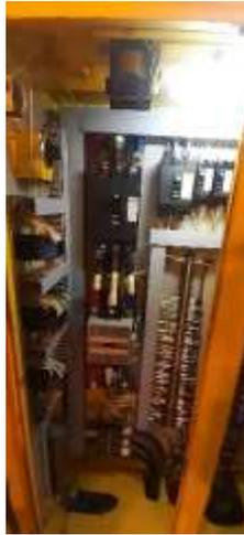
Para el montaje de los equipos se necesita la instalación de riel din para el correcto anclaje de los módulos y borneras de conexión, se ha montado los equipos de control, relés auxiliares, borneras que son elementos necesarios para la implementación del nuevo sistema de control, figura 73 y 74.
