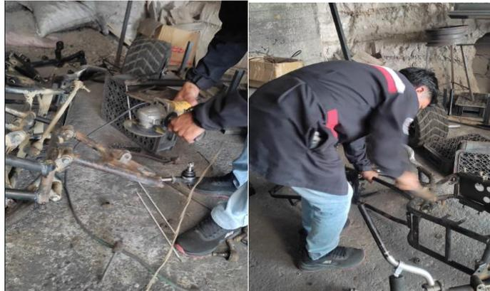
*Nota.* El gráfico representa el corte y curvado del material después de la previa inspección del material, con ayuda de herramientas como dobladoras de tubo y moladora.
